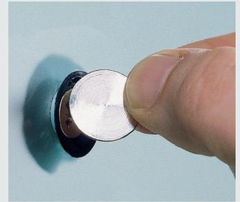
**4)** Flächenbündige Abdeckscheibe einclipen – fertig!
